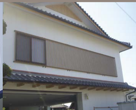
【格子□ -20X20 タイプ】 お寺に外壁化粧材として取付。(木目調塗装)
