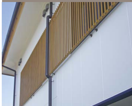
【格子□ -20X20 タイプ】 寺院の外壁化粧材として取付。(木目調塗装)
