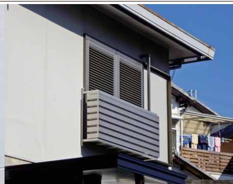
【ルーバー材□ -100X20】（オーダータイプ）。 横格子として使用。戸建住宅改修工事。
