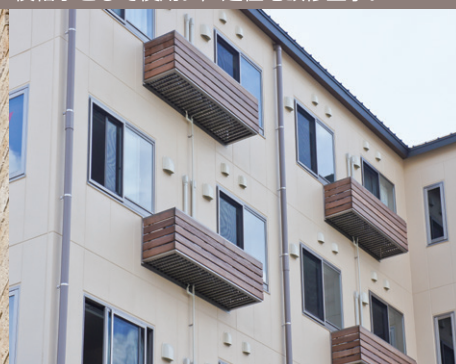
アルミ製の室外機台に木板を取付。 （オーダータイプ） RC 躯体、老人ホーム新築工事。
