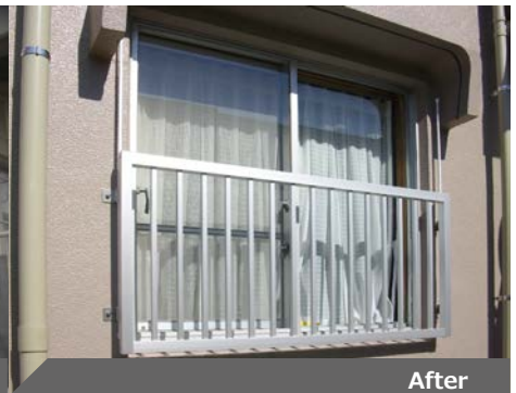
・集合住宅窓手すり 改修後 (アルミ製に取替え。)
