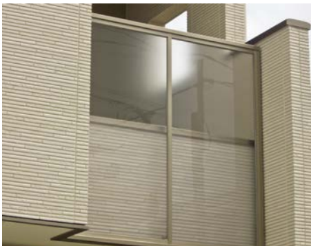
戸建住宅にバルコニーの手すりとして取付。
