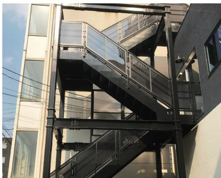
外部鉄骨階段に、防風スクリーンとして取付。
