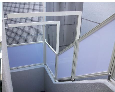
集合住宅外部階段に、目隠しフェンスとして取付。
