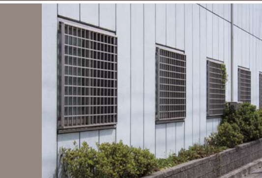
【格子 15X20 タイプ】 窓に面格子として取付。(ワンタッチブラケット)
