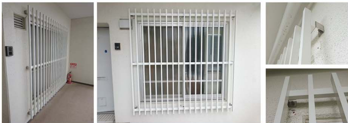
■共同住宅 正面躯体にオールアンカーを打設し、金具をセットした製品を吊るして取付。 格子：特注 20×30
