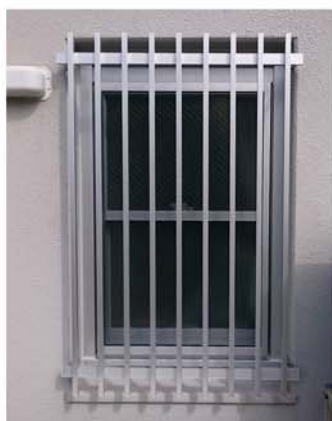
■ 共同住宅 上げ下げ窓に取付 格子：20×20 角 格子 Pic：100 L型ブラケット使用
