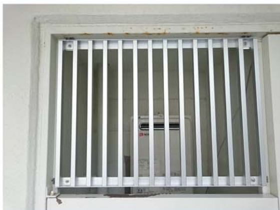
■ 集合住宅 PS に取付 格子：15×20 角 格子 Pic：50 スチール枠に直止め
