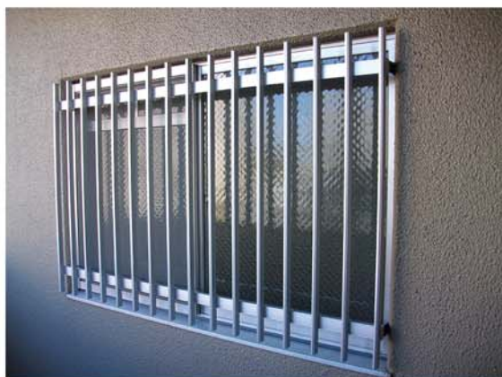
■ 集合住宅 引き違い窓に取付 格子：駒型 格子 Pic：100 カチコミ式ブラケット使用
