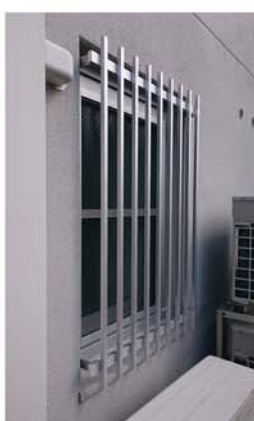
■ 共同住宅 上げ下げ窓に取付 格子：20×20 角 格子 Pic：100 L型ブラケット使用
