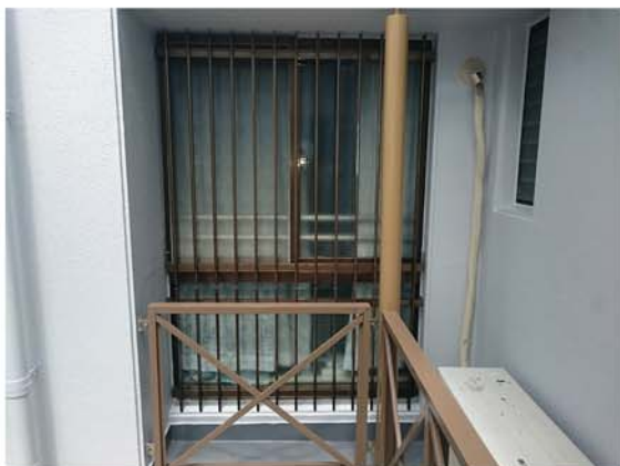
■ 集合住宅 引き違い窓へ取付 格子：駒型 格子 Pic：100 カチコミ式ブラケット使用
