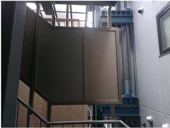
■共同住宅 階段部に柱を立てて取付 枠：1型 アルミ柱に金具止め
