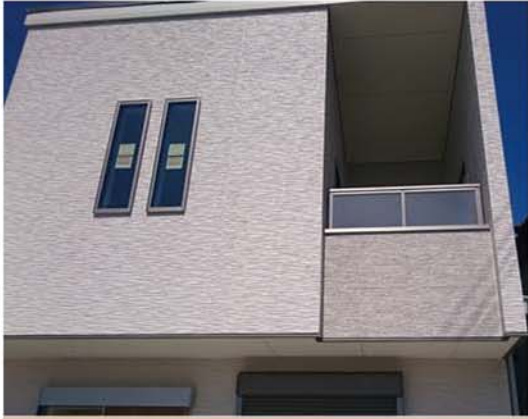
■木造住宅 ベランダ手摺として取付 枠：1型 + 上下笠木 入隅用Lブラケット使用
