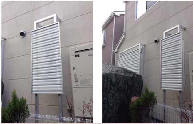
■木造住宅 1階 窓に目隠しとして取付 枠：1型 柱に金具を付けて固定
