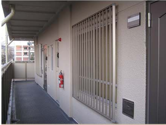
■共同住宅 引き違い窓に取付 壁持出し用 L 抱合せブラケット使用
