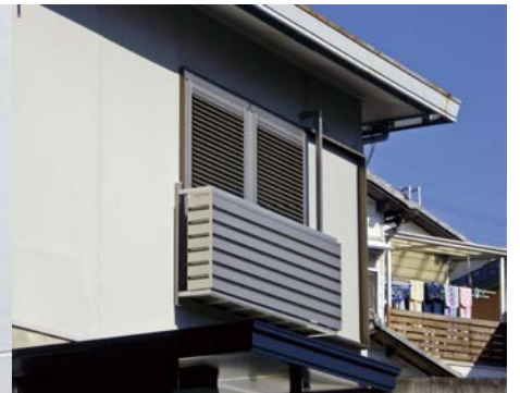
【ルーバー材□ -100X20】 (オーダータイプ)。横格子として使用。戸建住宅改修工事。
