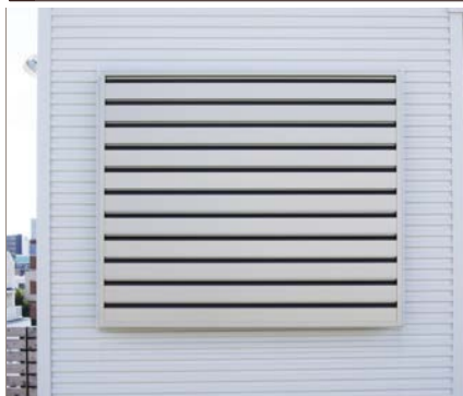
【アルミルーバー / ステンカラー】 戸建住宅窓の目隠しとして取付。
