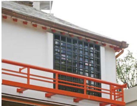
【格子 30X30 タイプ】 神社に面格子として取付した和の格子。
