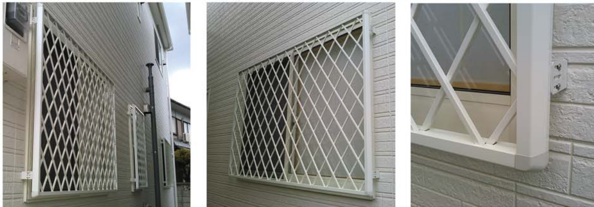
■木造住宅 1階 引き違い窓に取付 枠：TN型 L抱合せ壁持出しブラケット使用
