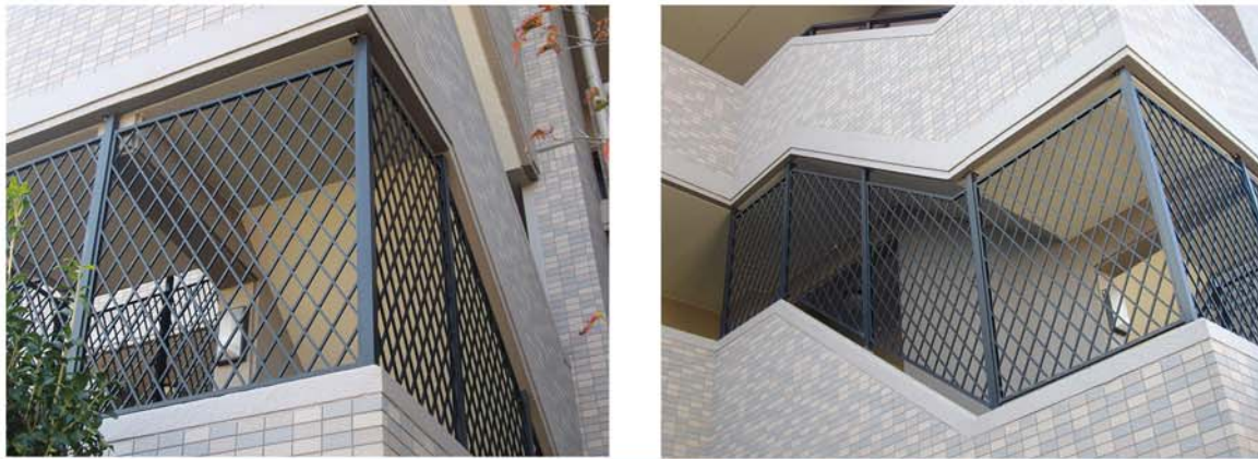
■共同住宅 RC造 階段部に柱を立てて取付 枠：2型 アルミ柱に直止め
